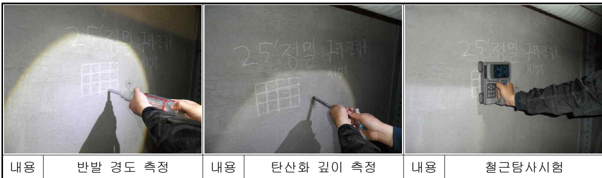
【사진 1.5】 구리인출 전력구 재료시험 전경
